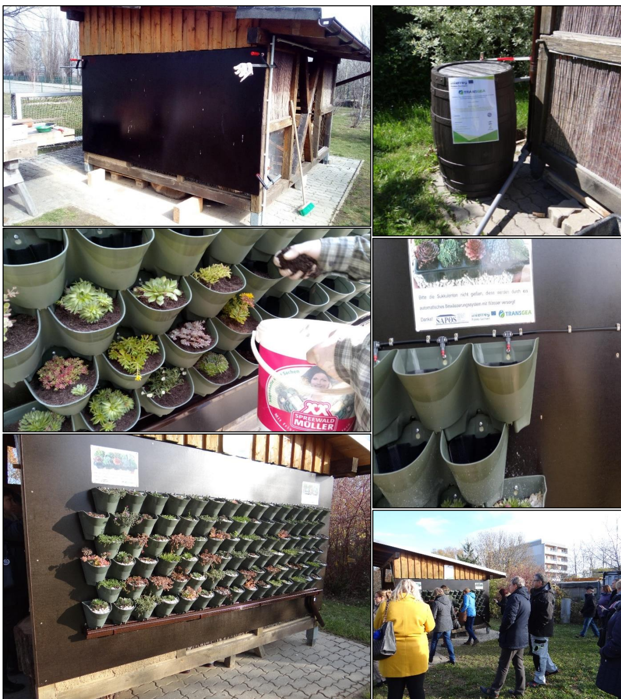
Rys. 7 Zdjęcia dokumentują tworzenie zielonej ściany - zarówno montażu kubeków na rośliny jak i systemu nawadniającego (składającego się z beczki zbierającej wodę z altanki i systemu rurek rozsączających zebraną deszczówkę do poszczególnych kubeków). Na ostatniej fotografii widać grupę polskich urzędników z regionu wsparcia, która w ramach 2 wizyty studyjnej miała okazję zobaczyć i posłuchać informacji o przebiegu realizacji mikoradaptacji wykonanych w ramach projektu TRANSGEA (zdj. SAPOS).
