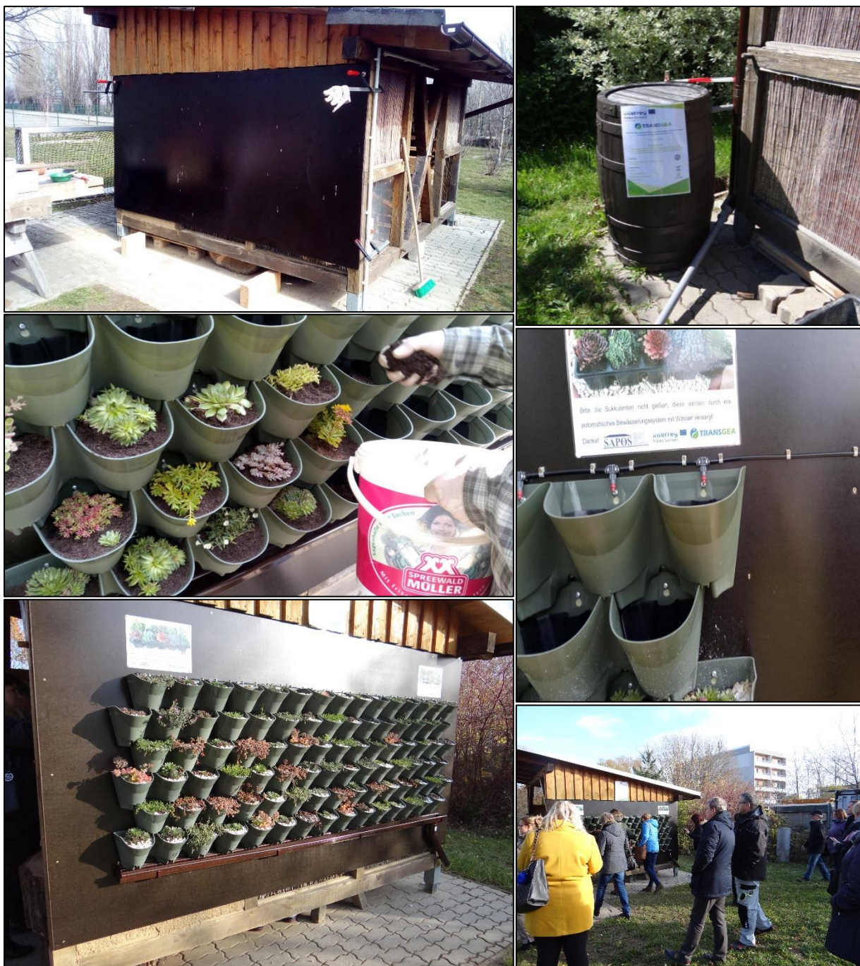
Abb. 7 Die Bilder dokumentieren die Fertigung der grünen Wand – sowohl Montage der Eimer für die Pflanzen als auch des Bewässerungssystems (das aus einem Fass besteht, das das Wasser aus der Gartenlaube auffängt sowie aus einem Rohrsystem zur Verteilung des aufgefangenen Regenwassers in die einzelnen Eimer). Auf dem letzten Bild ist eine Gruppe der polnischen Beamten aus der Förderregion sichtbar, die im Rahmen der 2. Studienreise die Möglichkeit hatte, die Informationen über den Verlauf der Realisierung der im Rahmen des Projektes TRANSGEA ausgeführten Mikroanpassungen zu hören und zu sehen. (Foto SAPOS)).
